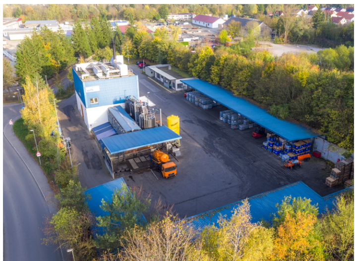
In der CP-Anlage am GSB-Standort Augsburg werden die Sickerwässer der Sonderabfalldeponie Raindorf – jährlich etwa 7000 Tonnen – behandelt und entsorgt. FOTO: GSB
