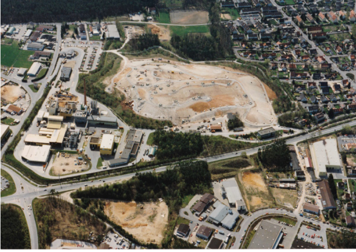
Die 1968 eingerichtete Deponie Schwabach wurde sukzessive zu einem Entsorgungsbetrieb mit Verbrennungsanlage ausgebaut. Allerdings erwies sich der Betrieb, der zur Sonder-Abfall-Entsorgung Franken (SEF) gehörte, im Laufe der Jahre als unrentabel. Im Jahr 2000 fusionierten SEF und GSB. 2005 wurde der Betrieb in Schwabach eingestellt. FOTO: STAATSARCHIV MÜNCHEN
